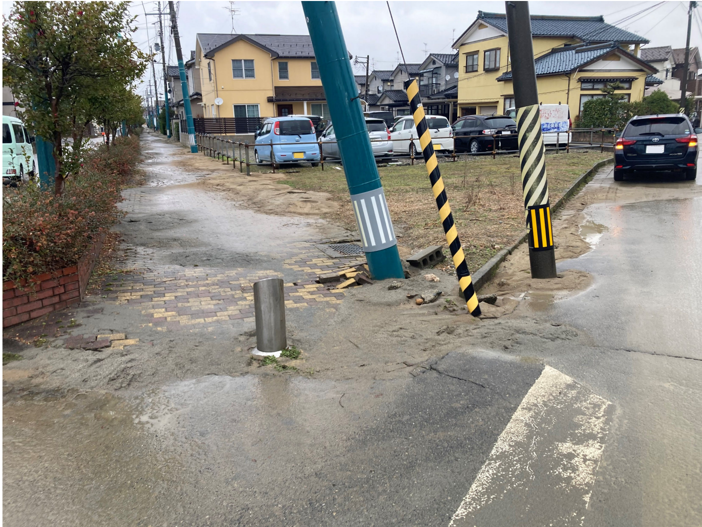
歩道から噴砂と電柱の沈下・傾き
