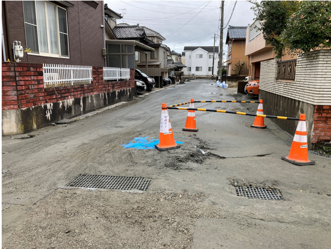
道路面からの噴砂
