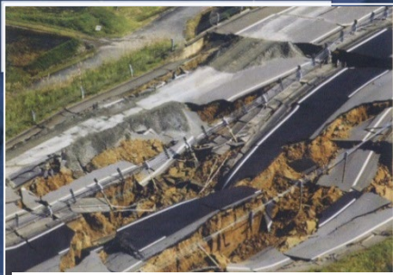
高速道路の盛土破壊(関越自動車道) 2)
