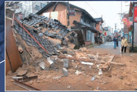
倒壊家屋(穴水町大町)穴水町は輪島市に次いで全壊棟数が多かった。
