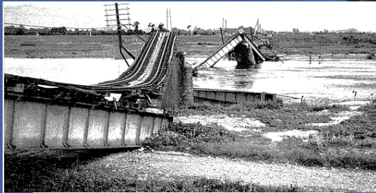
九頭竜川鉄橋の被災状況(朝日新聞社)
