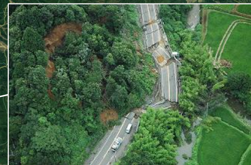
地すべりによる道路被災(国道8号大積) (朝日航洋(株))
