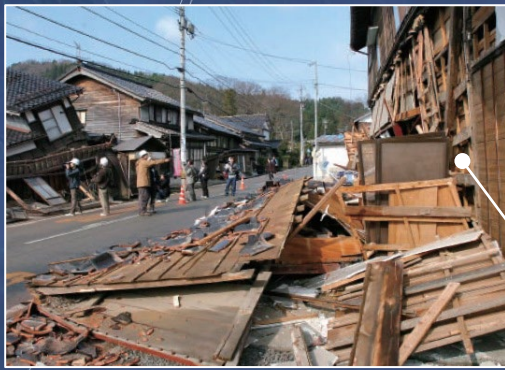
全壊棟数が最も多かった輪島市の住宅被害の状況(輪島市門前町館)
