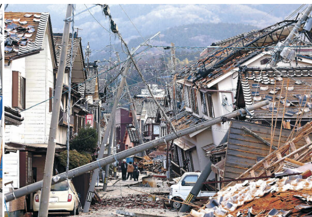
輪島市等の家屋倒壊
