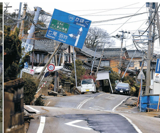
内灘町の液状化被災
