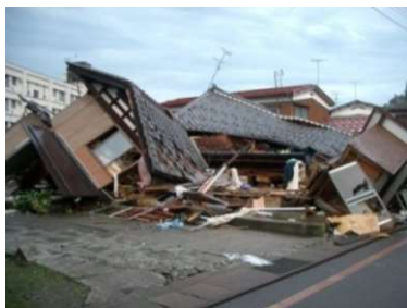
中越地震 川口町倒壊家屋
