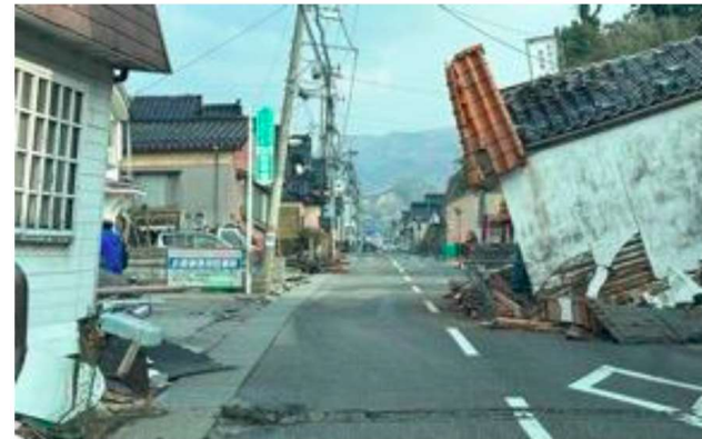
倒壊家屋群の状況
