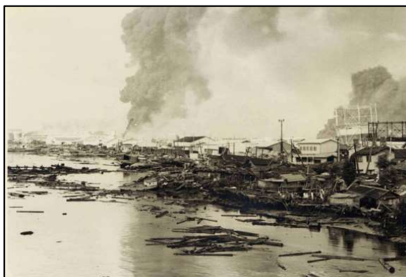
新潟地震 信濃川河口付近の被害
