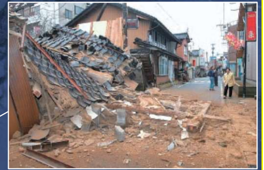
倒壊家屋(穴水町大町) 穴水町は輪島市に次いで全壊棟数が多かった。
