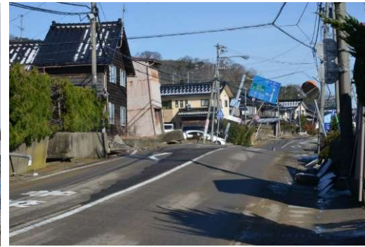
液状化による被害
