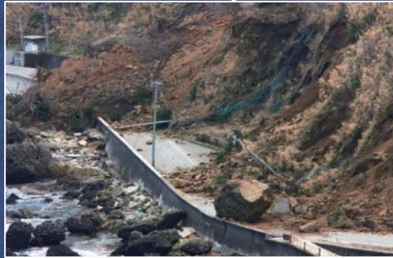
地区を孤立させた土砂崩れ(門前町深見地区)
