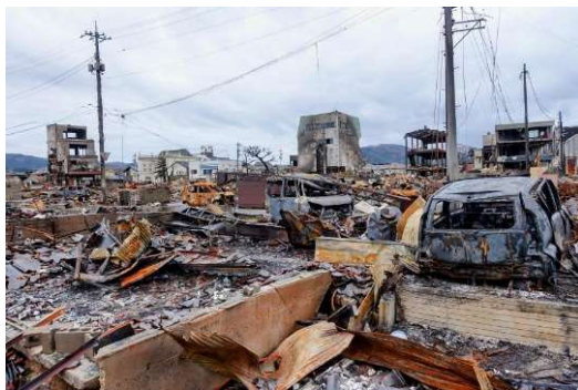
火災による建物被害
