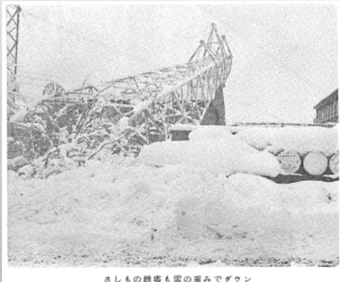
さしもの鉄骨も雪の重みでダウン
